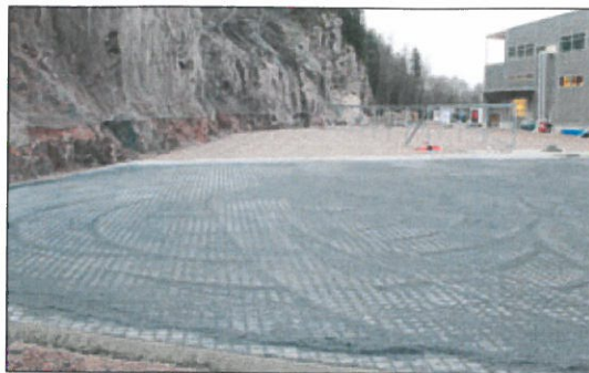
Utleiesenteret på Dalen Næringspark har fått dekke med permeabel belegningsstein.
